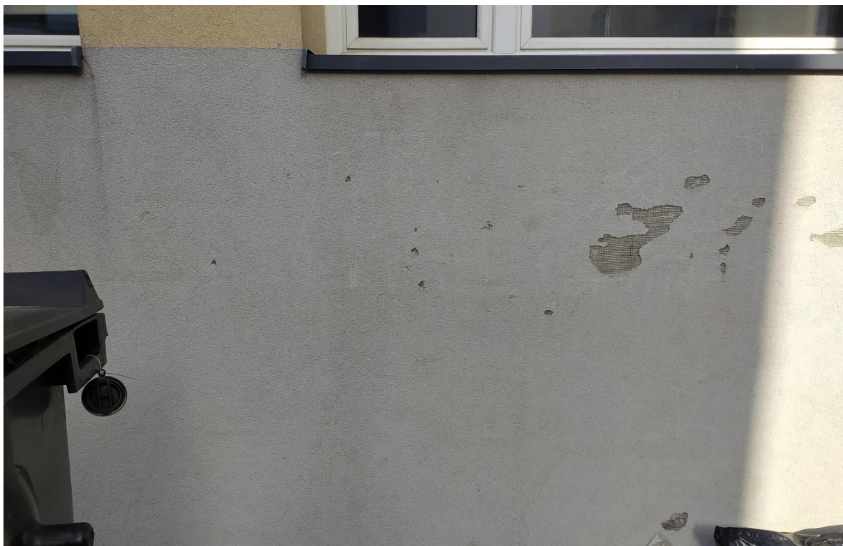
Fot. 6. Ubytki w tynku na elewacji południowej
